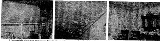
L'ensemble n'est pas entretenu depuis de nombreuses années, les dépendances restantes sont à démolir, quant à la maison de construction ancienne, elle n'a pas d'isolation, ni sous la toiture (charpente en bois et tuiles), ni sur les murs en briques, ni sur les fenêtres (menuiseries en bois et volets en fer) et elle n'a plus de chauffage à part des radiateurs mobiles électriques, le tout est en très mauvais état, sauf le compteur électrique qui a été changé récemment.
