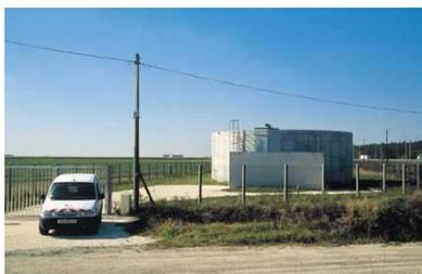
Cette station est composée du **forage de Jarry** (voir plus haut), d'une bache d'accumulation d'une capacité de 500 m<sup>3</sup>, et d'un pompage de reprise.
