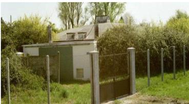
Cette station est composée du **forage de Moutine**, d'une bache d'accumulation d'une capacité de 1000 m3, et d'un pompage de reprise.
