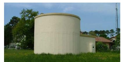
Le génie civil de la bache est vieillissant, des fuites ont été constatées. Une reprise de l'étanchéité du réservoir est à réaliser.
