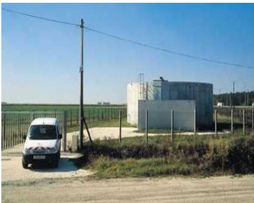
Cette station est composée du **forage de Jarry**, d'une bache d'accumulation d'une capacité de 500 m<sup>3</sup>, et d'un pompage de reprise.
