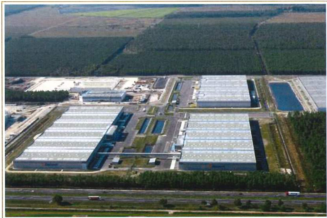
Bâtiments de logistique sur le secteur Pot au Pin
