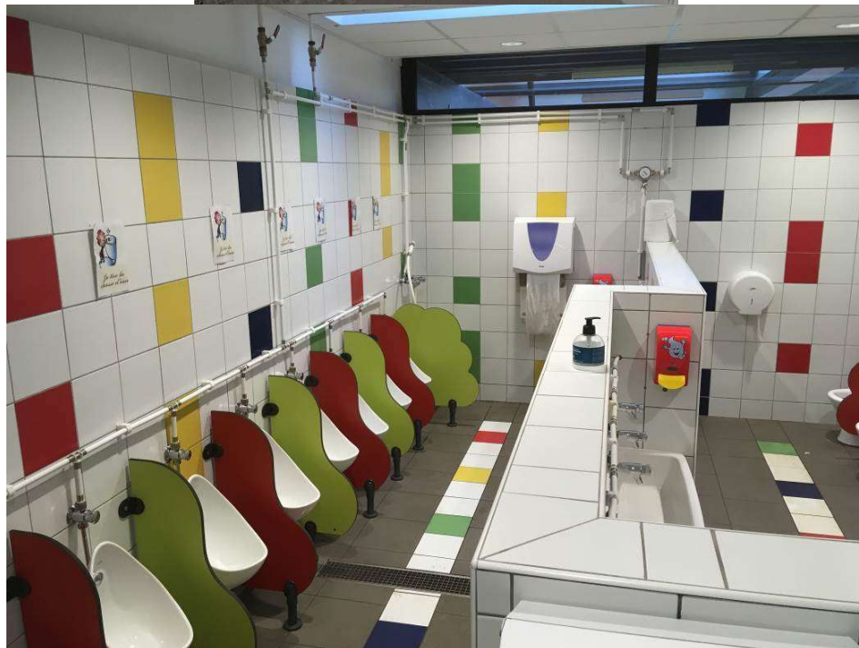
Travaux de rénovation des blocs sanitaires avec création d'un cabinet d'aisance pour les personnes handicapées
