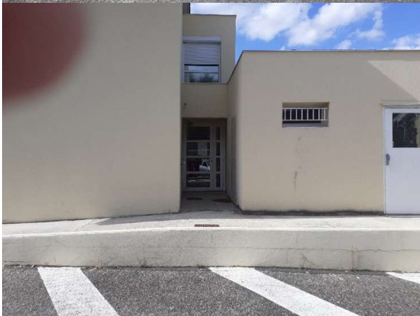
Réalisation d'une rampe d'accès vers couloir sur le côté du bâtiment
