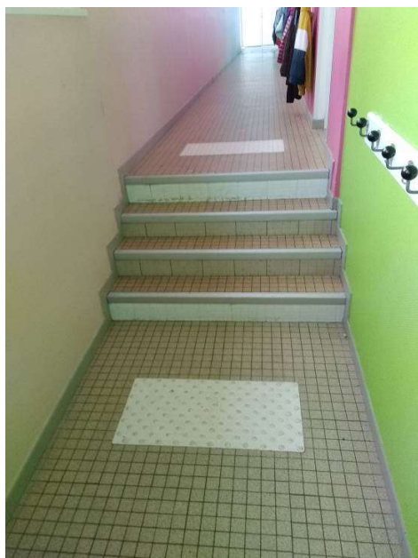
Mise en place de contraste visuel, dalles podotactiles et mise aux normes des cabinets d'aisances
