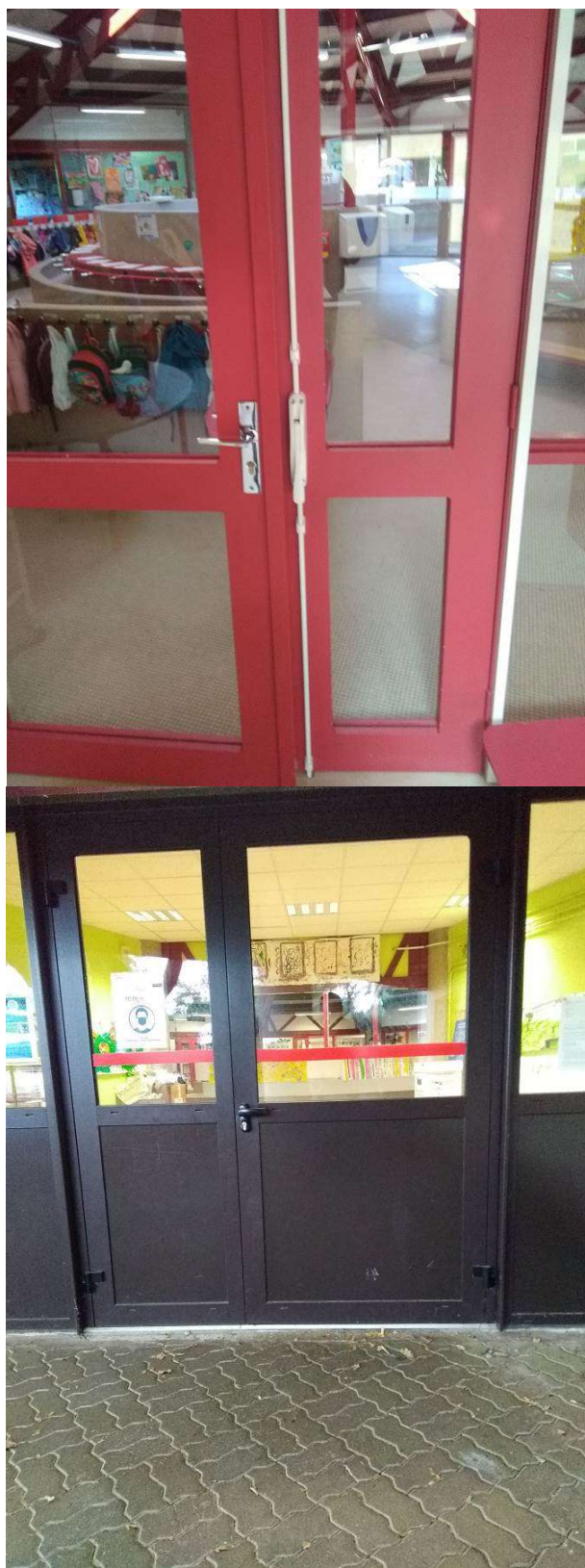
Changement de la porte d'entrée et mise en place de crémones
