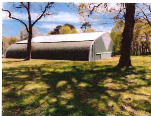
Tennis couverts de Canéjan Réfection de la toiture – 2022
