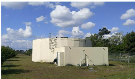
Cette station est composée du **forage de Jarry**, d'une bache d'accumulation d'une capacité de 500 m<sup>3</sup>, et d'un pompage de reprise.
