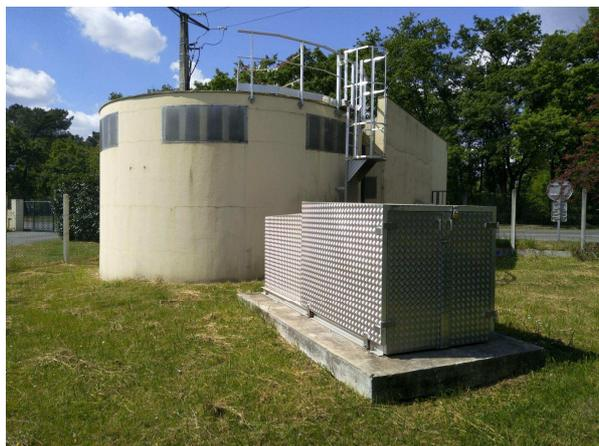
Cette station est composée du **forage de Bouzet**, d'une bête d'accumulation d'une capacité de 60 m3, et d'un dispositif de pompage de reprise.
