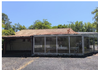
Maison- façade arrière
