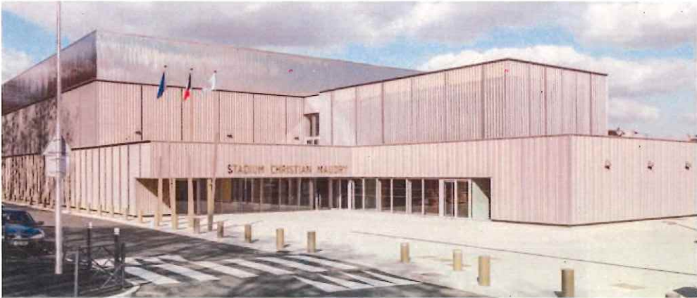
Architectes Engasson et associés Stadium HGF - Hugel sur Marie
