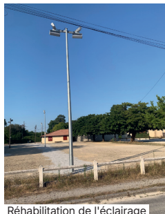
Réhabilitation de l'éclairage
