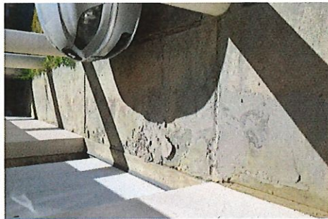
Coursive Réfection cours terme
